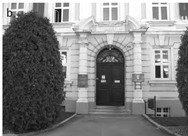
Slika 4: Vhod v objekt – (a) avtomatska drsna vrata, (b) primer ovire pri vhodnih vratih (foto: arhiv UIRS)
