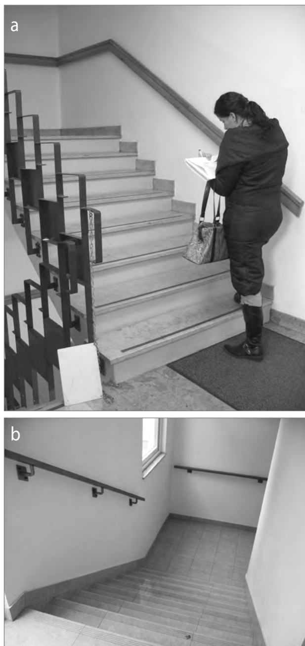
Slika 7: Stopnice – (a) ustrezno (neprekinjeno) držalo, (b) neustrezno (prekinjeno) držalo (foto: arhiv UIRS)
