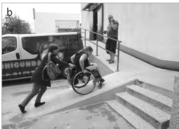
Slika 3: Višinske razlike na dostopni poti do objekta – (a) klančina z ustreznim naklonom, (b) primer neustrezne klančine (foto: arhiv UIRS).
