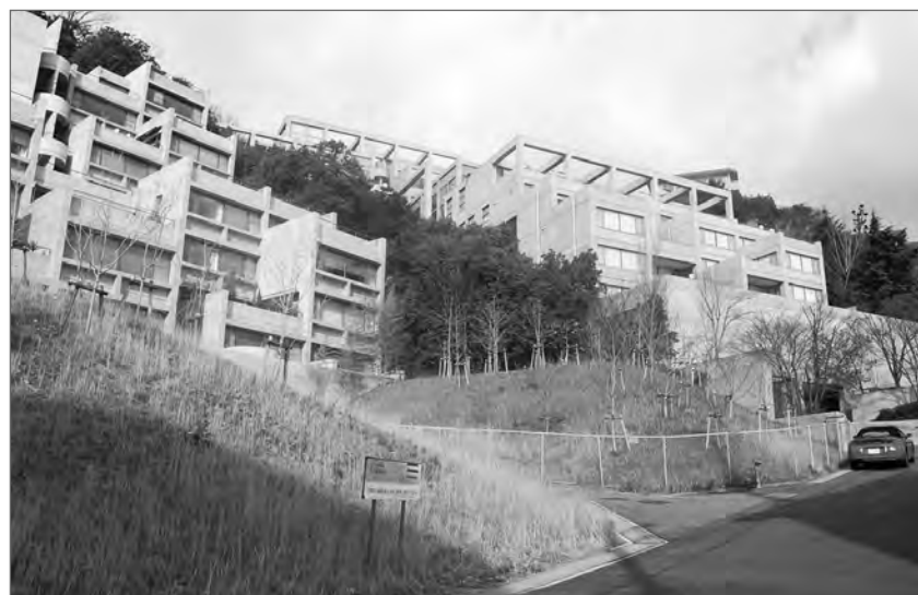
Slika 10: Andovi stavbi Rocco Housing I in II, nastali med letoma 1983 in 1993 (foto: Raphael Azevedo Franca).
