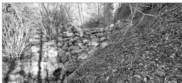
Slika 5: Prečne pregrade: (a) lesena kašta, (b) betonska kašta, (c) slapišče, sestavljeno iz velikih skal, in (č) zložba skal v betonu (foto: Franc Vidic).
