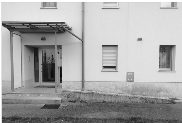
Slika 8: Ustrezno opremljen vhod v večstanovanjski blok v naselju Gmajnica (foto: Ženja Brezovar)
