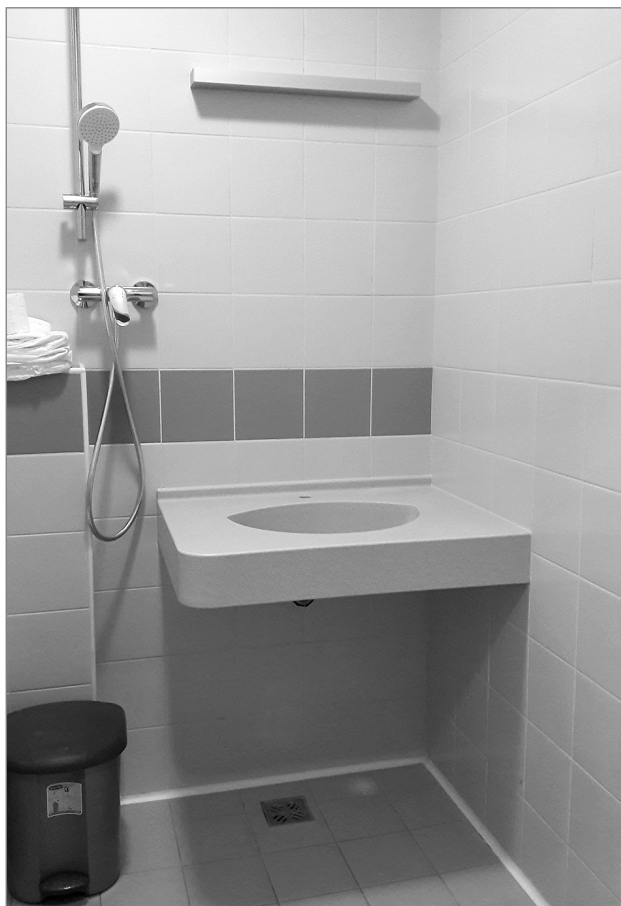
Slika 6: Prenovljena zelo majhna kopalnica tik pred dokončano montažo (manjka pipa). Ob umivalniku je še dodatna pipa za tuširanje za lažjo nego, predvsem oseb na vozičku. V prostoru je na drugi strani še nivojski prostor za tuširanje (foto: Barbara Železnik Bizjak).
