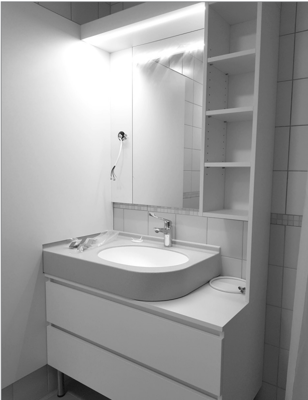
Slika 4: Montaža obloge in omare okrog konzolnega umivalnika, ki je bil prvotno že nameščen v kopalnici. Poseganje v obodni zid ni bilo dovoljeno. Uporabnik je pridobil dovolj odlagalnega in shranjevalnega prostora (foto: Barbara Železnik Bizjak).
