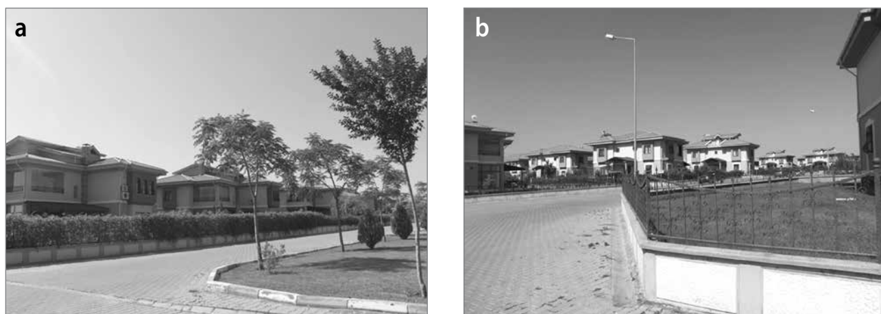
Slika 5: (a) sprednja in (b) zadnja stran samostojnih hiš v ograjeni skupnosti Gekuşagi (foto: İlham Yılmaz-Ay)
