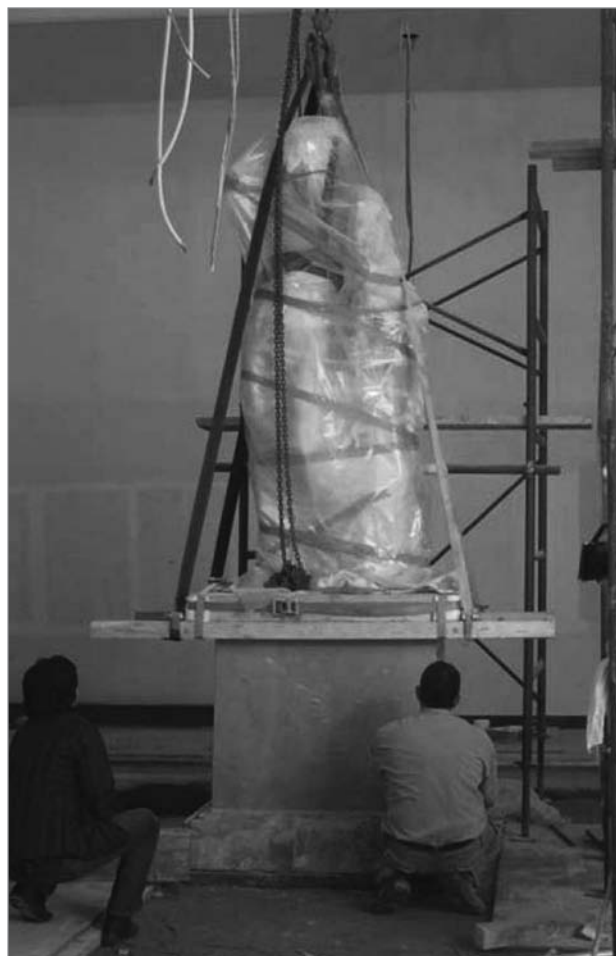
Slika 3: Namestitev kipa na potresno izolacijo (vir: Koumouisis, 2007)
