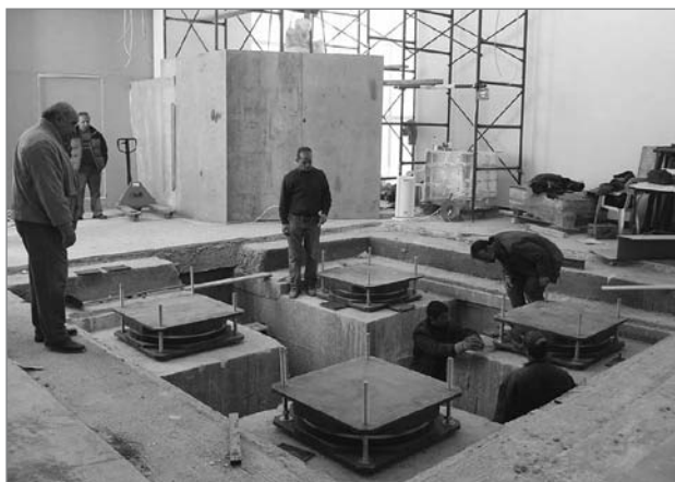
Slika 2: Namestitev potresne izolacije kipa Hermesa v Olimpiji (vir: Koumouisis, 2007)
